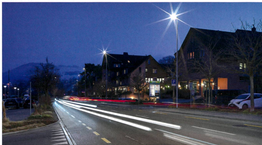
Ein lokaler Sensor erfasst die Witterungsverhältnisse. Die Leuchten passen automatisch ihre Lichtverteilung an, um die Strasse auch bei Nässe gleichmässiger und möglichst blendfrei auszuleuchten.
