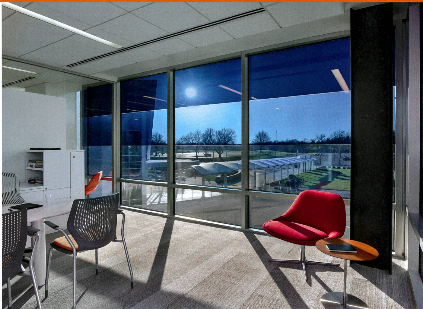
Exemple de vitrage divisé verticalement en trois zones dont l'opacité peut être réglée individuellement.
