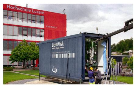
**Figure 1** Le conteneur de mesure de la lumière sur le campus de la HSLU, à Horw, lors de l'installation du vitrage électrochrome.
