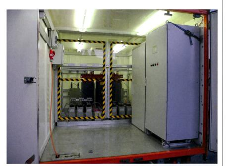
Bild 3 Das Innere der betriebsbereiten Rundsteueranlage.
