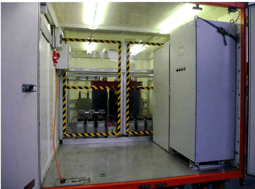
Bild 3 Das Innere der betriebsbereiten Rundsteueranlage.
