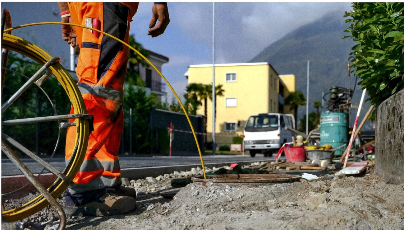
Les installations de tuyaux existantes devraient être utilisées dans la mesure du possible et permettre ainsi de réduire massivement les coûts.
