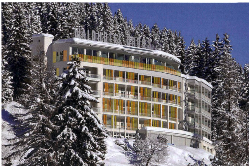
Entwurf einer Solarfassade für das «Hotel Waldhaus Davos», bei der bewegliche Paraventelemente Schatten spenden.
