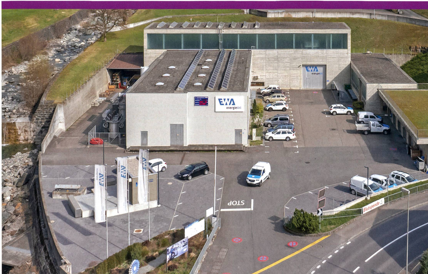
La centrale hydroélectrique de Bürglen alimente plus de 22 000 ménages.
