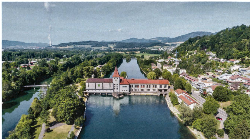
La centrale telle qu'elle se présente aujourd'hui. En arrière-plan, on aperçoit la fin de la digue centrale controversée.
