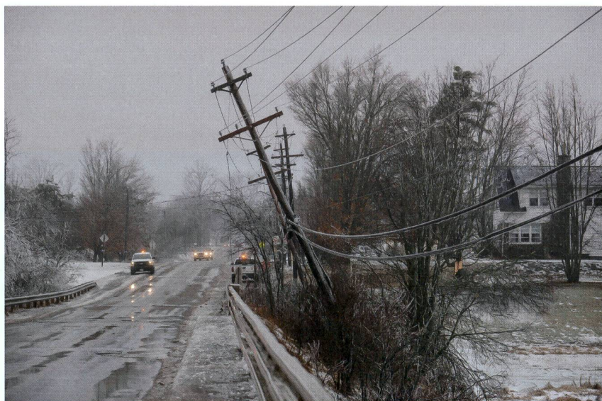
Bild 2 Mehrere Zentimeter dicke Eisschichten auf den Leitungen liessen im Jahr 2017 die Masten wie Dominosteine fallen. 600 Masten mussten ersetzt werden, knapp 300 000 Kunden waren ohne Strom.
