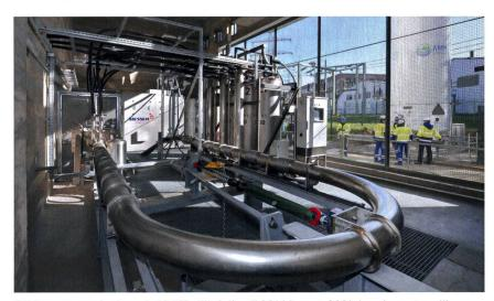
Câble supraconducteur de 10 kV utilisé d'avril 2014 à mars 2021 dans le centre-ville d'Essen. Le réservoir d'azote se trouve à droite, à l'extérieur du bâtiment.
