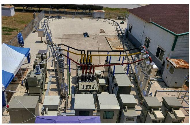
Test d'un câble HTS (23 kV, 60 MVA) dans le district de Gochang, en Corée du Sud.
