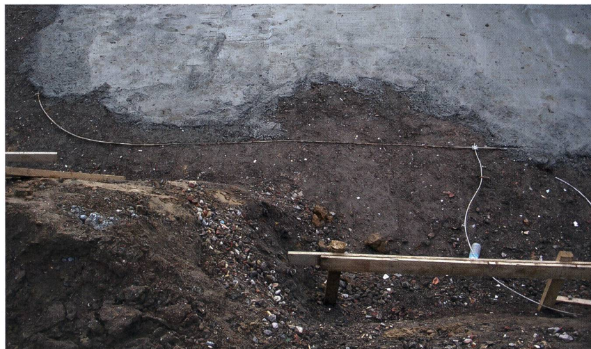
Innere Blitzschutz: Fundamenterder in der Baugrube eines Einfamilienhauses.
