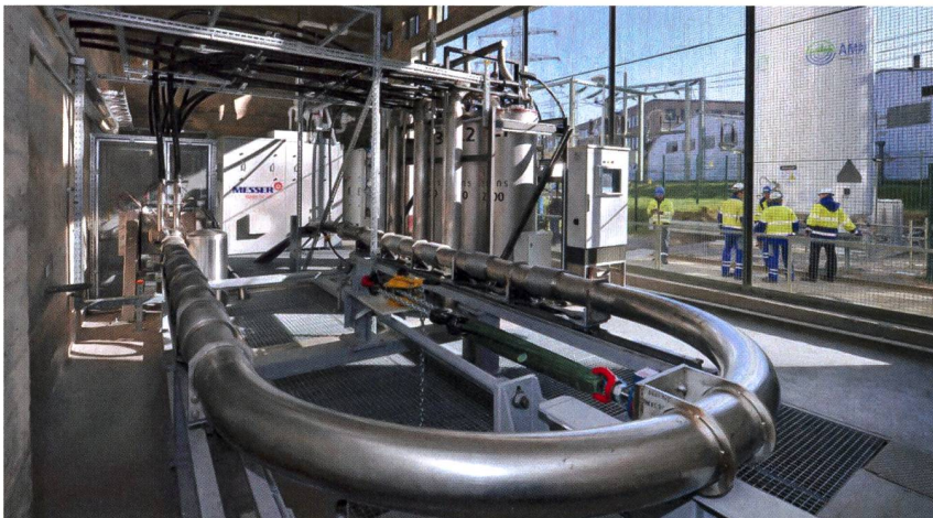
Supraleitende 10-kV-Stromleitung, die von April 2014 bis März 2021 in der Innenstadt von Essen genutzt wurde. Rechts ausserhalb des Gebäudes steht der Stickstofftank.
