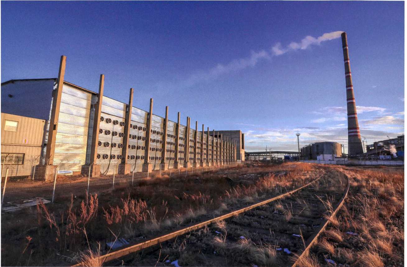
Kryptowährungs-Rechenzentrum neben einem Kohlekraftwerk in Kasachstan.
