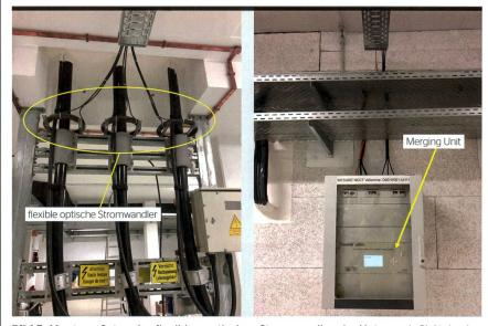
$\textbf{Bild 5} \ \ \text{Montage-Setup des flexiblen optischen Stromwandlers im Unterwerk Châtelard}.$
