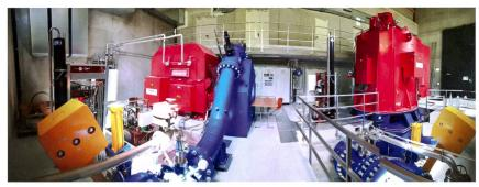
Die neue Kraftwerkszentrale Sägengüetli in Flums mit den zwei Wasserturbinen und Generatoren.
