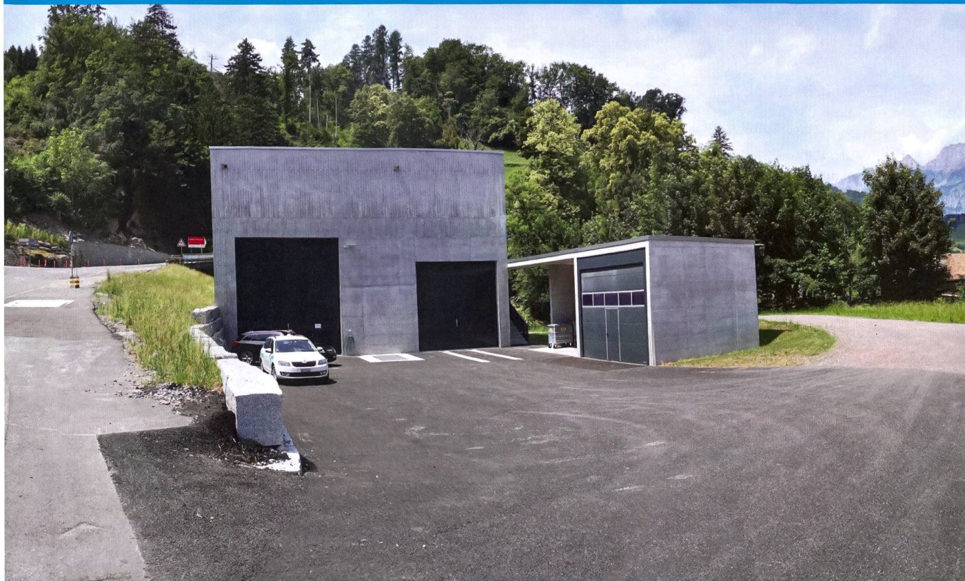
Kraftwerkszentrale Sängüetli in Flums.
