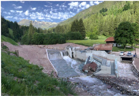
Die Wasserfassung und die Fischtreppe Bruggwiti im Schilstal, oberhalb Flums.
