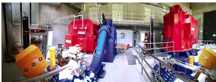
Die neue Kraftwerkszentrale Säggüetli in Flums mit den zwei Wasserturbinen und Generatoren.
