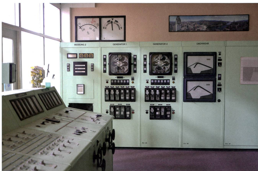
Operational Technology ohne Risiko einer Cyberattacke: Bis 2003 wurde hier das Kraftwerk gesteuert, die Generatoren synchronisiert und die Wassermenge des Wehrs manuell eingestellt.
