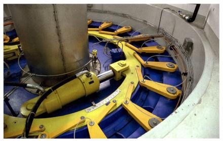
Der hydraulische Antrieb und die Stellhebel des Leitapparats für die vertikale Kaplanturbine.
