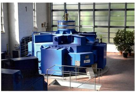
Einer der zwei zwanzigjährigen Generatoren der baskischen Firma Indar mit einer Nennleistung von 2,5 MVA in der Maschinenhalle.
