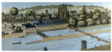
1878 war das Kraftwerk ein Wasserwerk: Turbinen- und Pumpenhaus im Letten. Transmissionsseile trieben mit rund 220 kW industrielle Betriebe auf der linken Limmatseite an.
