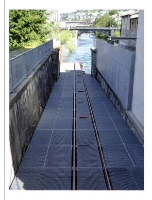
Bootsüberführung und Fischunterführung (unter den Schienen). Langboote bis 15 m können übersetzt werden. Die Überführung wird meist im Frühling und im Herbst von Pontonniervereinen genutzt, deren Bootshaus flussaufwärts liegt.
