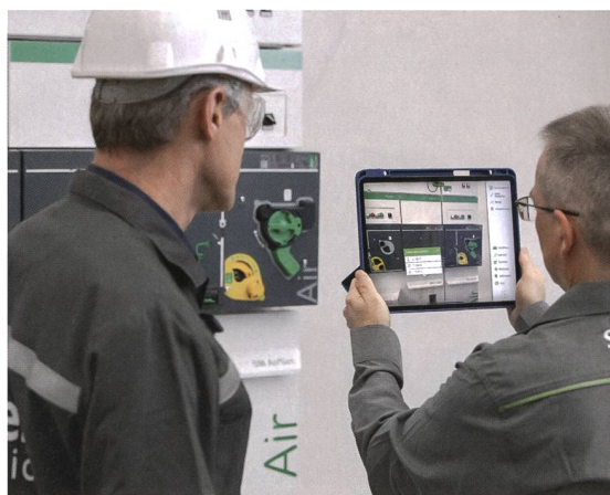
Digitale Überwachung des Gesundheitszustandes von Schaltanlagen.
