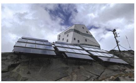
**Bild 4** Sonnenkollektoren (zwei mittlere Reihen) liefern Wärme für Heizung und Warmwasser. 2013 wurden zudem zusätzliche PV-Module installiert, um den Strom-Deckungsgrad zu erhöhen.
