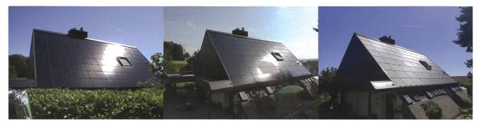
**Bild 4** Das Norddach des betroffenen Einfamilienhauses vor der Blendsanierung (links), bei der Bemusterung (Mitte) und mit den neuen satinierten PV-Modulen (rechts).
