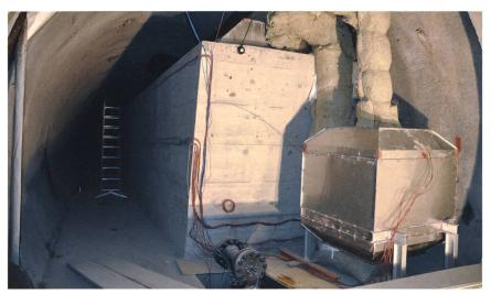
Sensibel-latenter thermischer Speicher in der Pilotanlage bei Pollegio. Links ist der mit Kieselsteinen gefüllte sensible Speicher, rechts der latente Speicher zu sehen. Der sensible Speicher ist 3,1 m hoch, 9,9 m lang und 4 m breit. Der latente Speicher ist etwa 1,5 m hoch, lang und breit.
