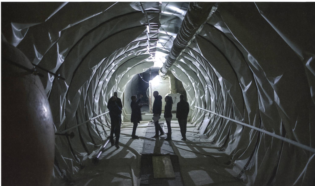
Speicherhohlraum in der Pilotanlage bei Pollegio.
