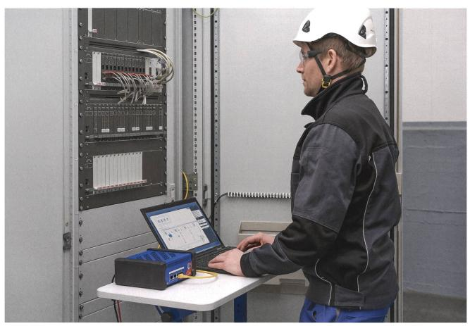
Eine Anlagenprüfung mit StationScout.
