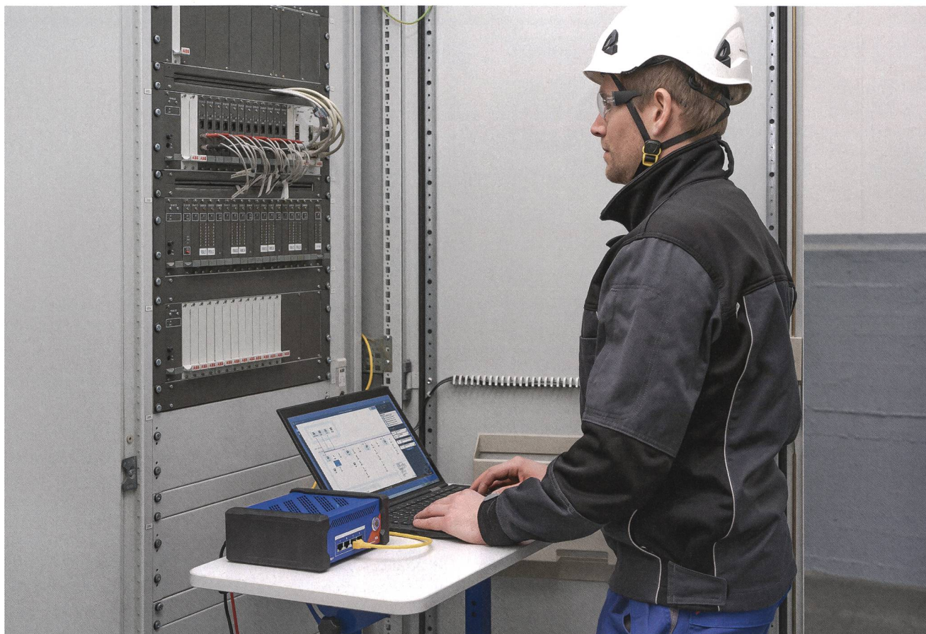
Eine Anlagenprüfung mit StationScout.
