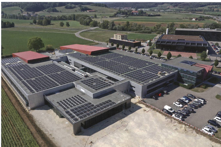
Sur le toit de l'entreprise Willemin-Macodel SA, la plus grande centrale PV de Delémont.
