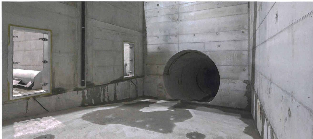
La chambre de mise en charge lors de sa construction.
