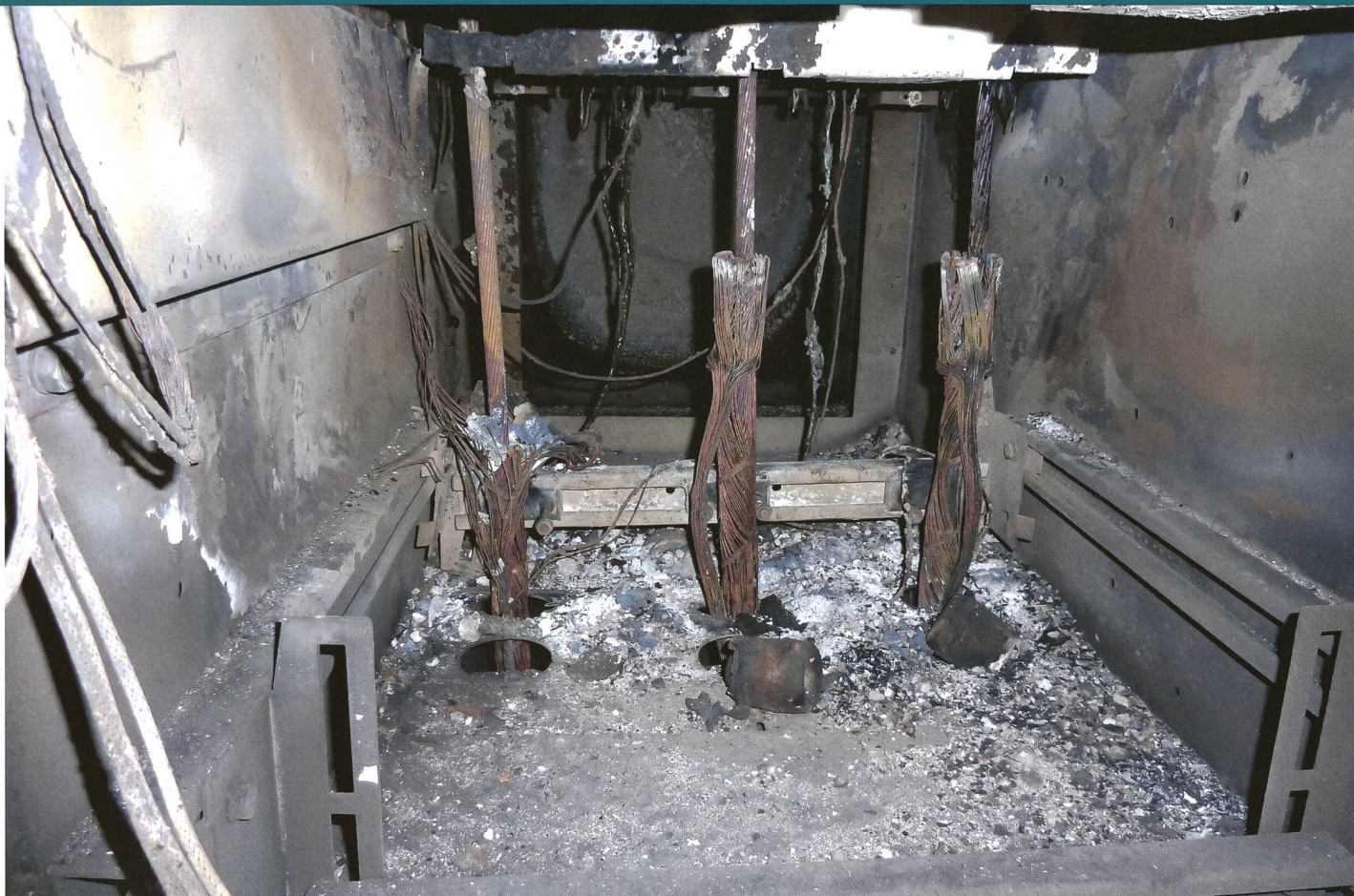
Zerstörte Zelle einer Mittelspannungs- Schaltanlage.
