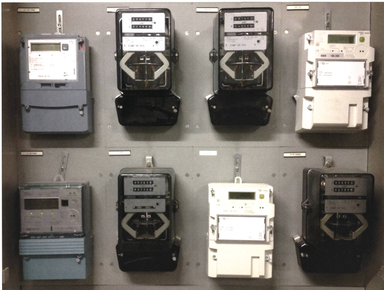
Armoire à compteurs d'un regroupement de consommation propre.
