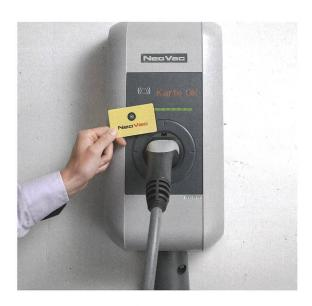
Nutzer identifizieren sich mittels RFID-Karte. Die Abrechnung der Energiebezüge erfolgt automatisch über die verbrauchsabhängige Energie- und Wasserkostenabrechnung.
