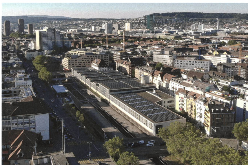
Dans le cadre d'un assainissement général, achevé en 2019, du dépôt de trams classé monument historique de l'Elisabethenstrasse, à Zurich, on a posé cette installation photovoltaïque de 470 kW, qui produit principalement du courant de traction pour les trams. À long terme, tous les dépôts de trams zurichois seront équipés d'installations PV.
