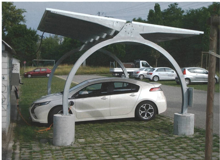
Der Solarcarport der BFH-TI in Burgdorf.
