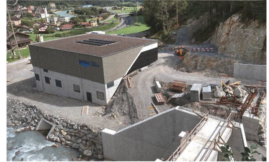
Das neue Kraftwerk Erstfeldertal.
