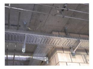
**Bild 9** Beispiel Kabeltragsystem mit grossflächiger Durchgängigkeit (4.4.4 Figur 24, empfohlene Ausführung). Nutzung als Potenzialausgleichsleiter und mit Anschluss an Bewehrung (Potenzialausgleich).
