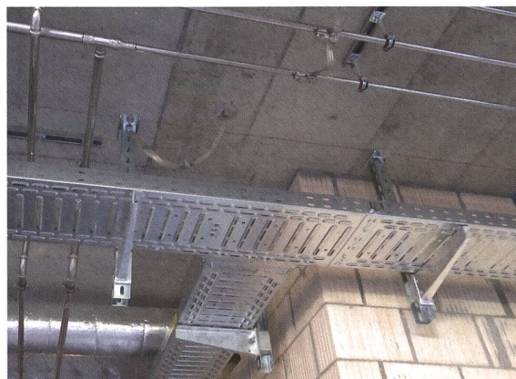
Bild 9 Beispiel Kabeltragssystem mit grossflächiger Durchgängigkeit (4.4.4 Figur 24, empfohlene Ausführung). Nutzung als Potenzialausgleichsleiter und mit Anschluss an Bewehrung (Potentialausgleich).
