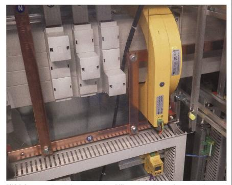
**Bild 4** Stromwandler mit Steuergerät einer Differenzstromüberwachungseinrichtung (RCM) in einer NSHV.
