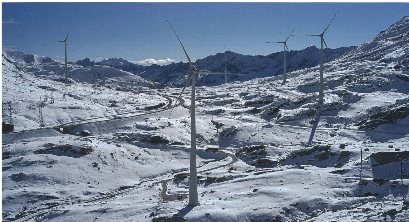
Le parc éolien du Saint-Gothard, comptant 5 éoliennes d'une puissance totale de 11,75 MW, a été inauguré à la mi-octobre 2020.
