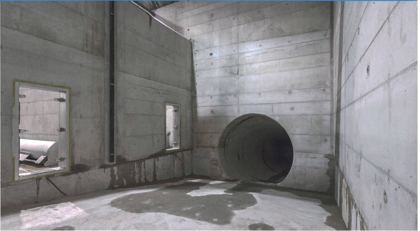
Druckaufbaukammer während des Baus.
