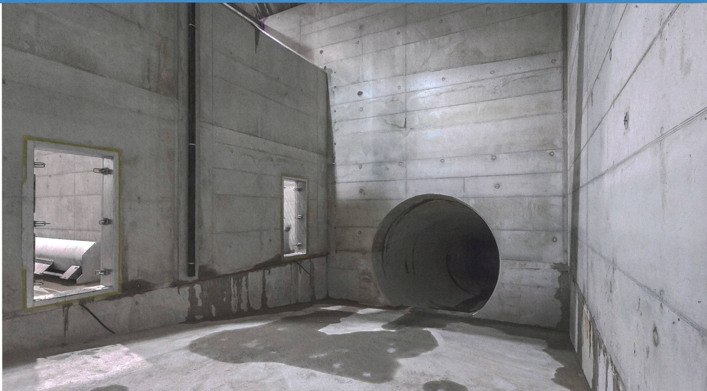
Druckaufbaukammer während des Baus.
