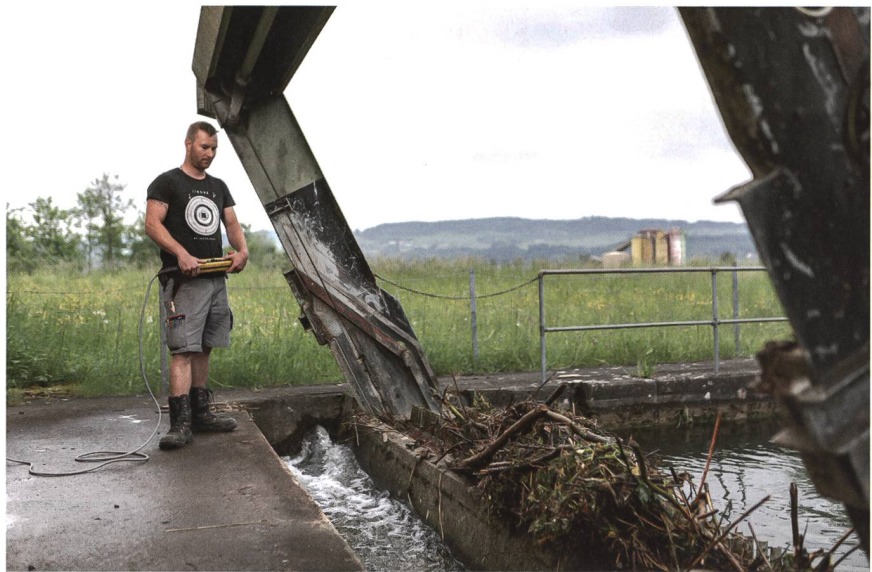
Wasserkraftwerksanlagen müssen punkto Gewässerschutz neuen Anforderungen gerecht werden.
