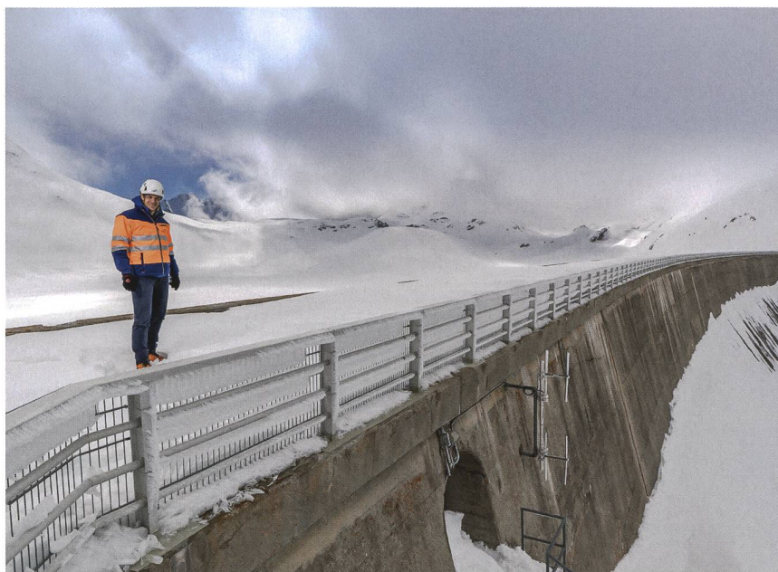
Le barrage de Gries dans le Haut-Valais.
