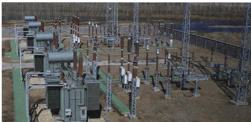
Bild 2 Freiluftanlage eines Bahnsumspannwerkes an 3 AC 220 kV 50 Hz mit je zwei Einphasenumspannern 31,5 MVA in V-Schaltung, davon zwei in Stand-by-Modus, an 3 AC 220 kV 50 Hz.
