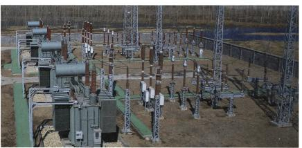
**Bild 2** Freiluftanlage eines Bahnumspannwerkes an 3 AC 220 kV 50 Hz mit je zwei Einphasenumspannern 31,5 MVA in V-Schaltung, davon zwei in Stand-by-Modus, an 3 AC 220 kV 50 Hz.
