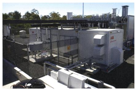
Bild 4 20-MVA-Phasenwandler in Wulkuraka (Queensland, AU), an 3 AC 110 kV 50 Hz.
