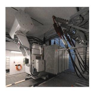
**Bild 3** 15-MVA-Frequenzund Phasenwandler in Stavanger (NO), an 3 AC 45 kV 50 Hz.
