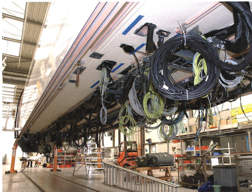
Bild 4 Kabelmenge in einem Zug.
