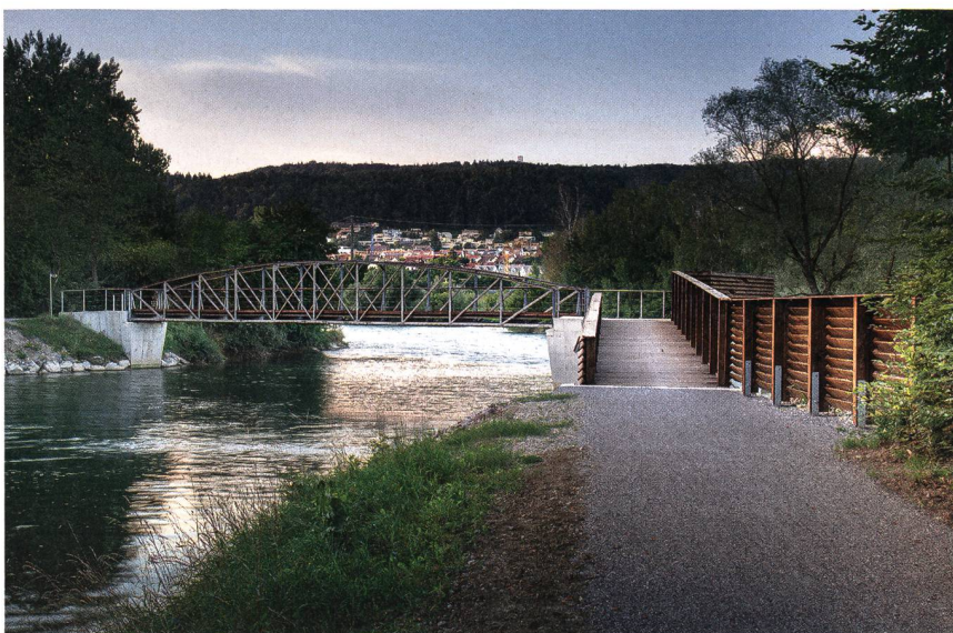
EKZ baute einen neuen Steg zur historischen Fachwerkbrücke, weil der Fussweg entlang der Limmat zugunsten des Naturschutzes aufgehoben wurde.
