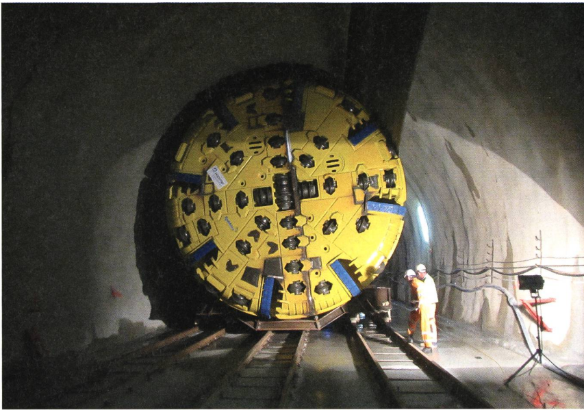
Bild 3 Doppelschildmaschine für den Vortrieb zwischen Maria Stein und Ovella.
