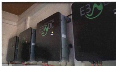
Solarwechselrichter im Gerkenhof, die in das Regelungskonzept eingebunden sind.
