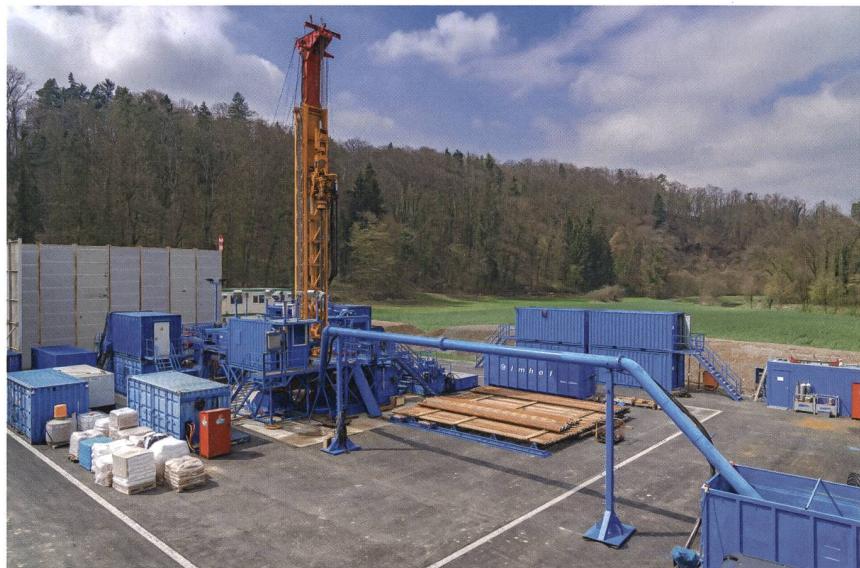
Mit Tiefbohrungen können die Eigenschaften, Schichtdicke und Einschlussfähigkeit des Opalinustons in den Standortgebieten genau erkundet werden.
