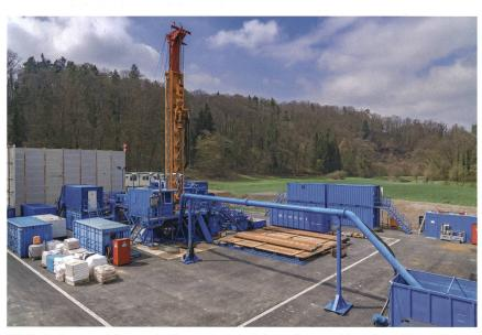
Mit Tiefbohrungen können die Eigenschaften, Schichtdicke und Einschlussfähigkeit des Opalinustons in den Standortgebieten genau erkundet werden.
