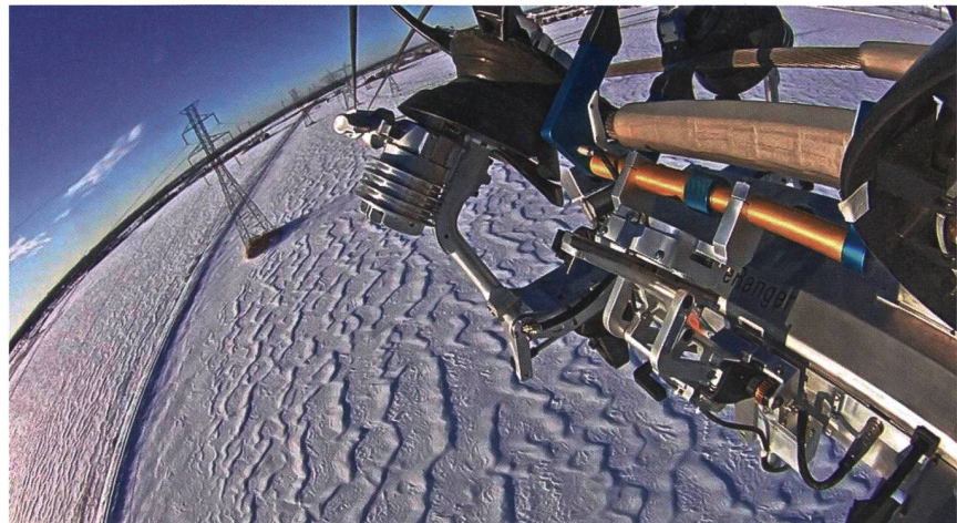
Figure 5 Réalisation de mesures sur un manchon de jonction, sous une tension de 735 kV.
