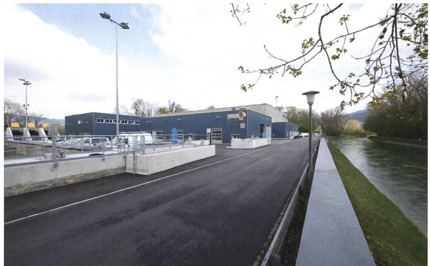
Hier am Standort von Limeco in Dietikon entsteht die weltweit grösste, industrielle Power-to-Gas-Anlage mit biologischer Methanisierung.
