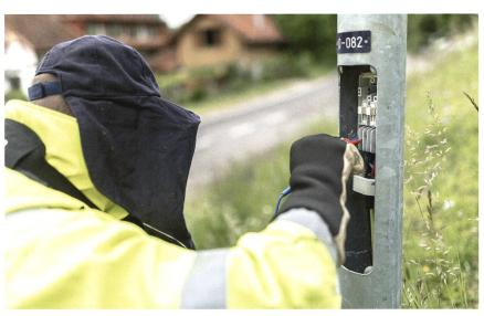
Beim Clean-Up werden Störquellen im Netz detektiert.
