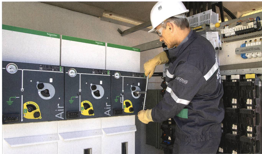
GreenAlp, der Energieversorger in Grenoble, setzt bereits auf SF 6 -freie Alternativen.
