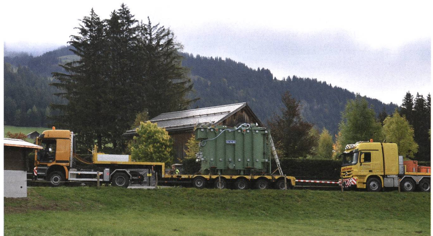
Bild 4 Transport eines Trafos in Saanen (BKW).
