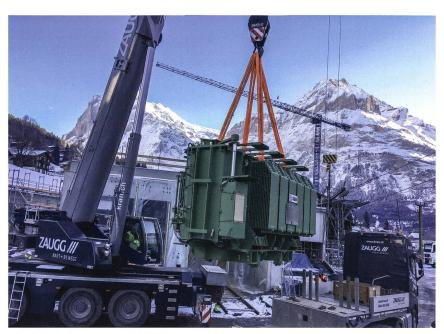
Bild 3 Anlieferung eines 25-MVA-Transformators in Grindelwald.
