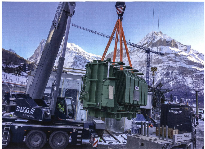
Bild 3 Anlieferung eines 25-MVA-Transformators in Grindelwald.
