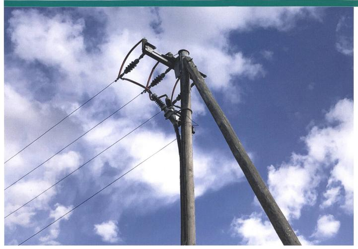
Ein Strommast vor La Punt Chamues-ch mit roter Isolation an den stromführenden Teilen.
