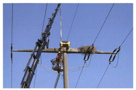
Freileitungsmonteure von Axpo errichten ein neues, stromschlagsicheres Nest für die jungen Weissstörche. Rechts daneben befindet sich das später entfernte Nest in gefährlicher Lage bei den Abspannisolatoren.
