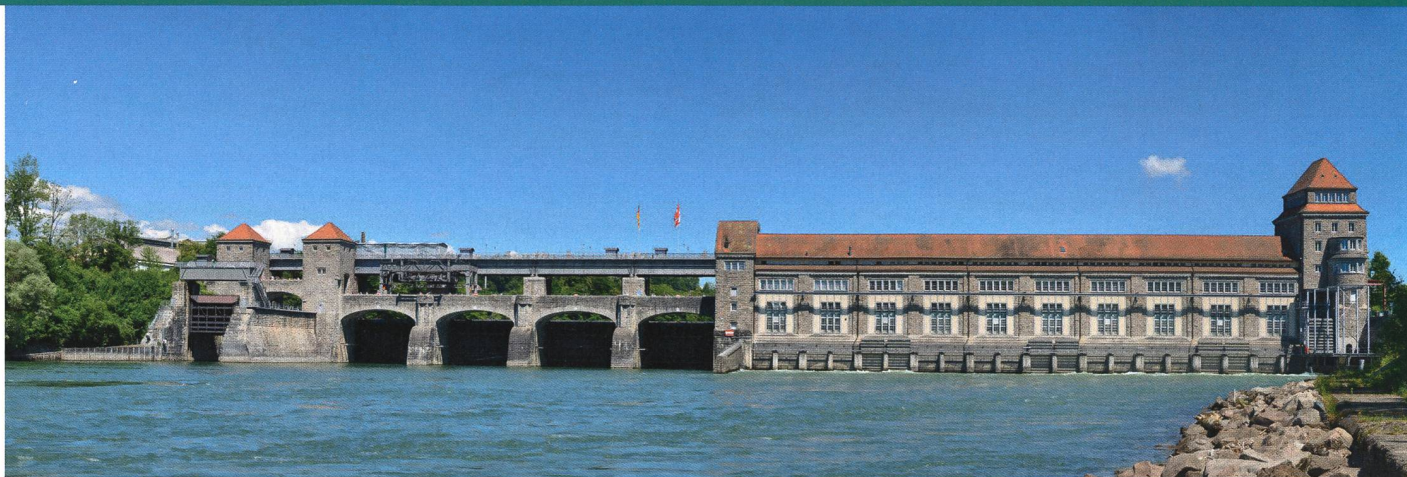
Staustufenunterseite des Kraftwerks Laufenburg.
