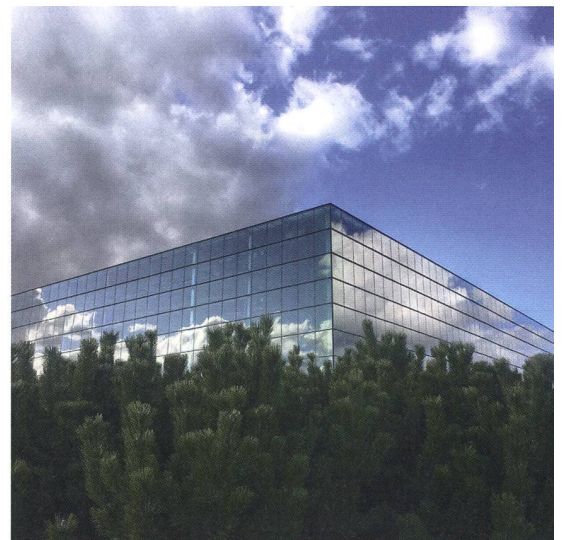
Grossflächig verglastes Gebäude.
