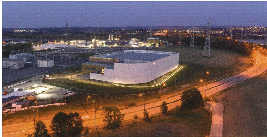
Die HGÜ-Konverterstation in Lixhe in Belgien.
