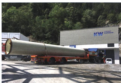
Kraftwerk Erstfeldertal wird gebaut.
