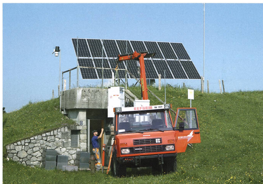
Die Anlieferung der SF 6 -freien Schaltanlage bei der unterirdischen Trafostation auf 1600 M.ü.m.
