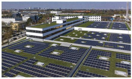
Auf dem Dach des Centro Tesoro ist die grösste innerstädtische PV-Anlage Münchens installiert. Mit einer Leistungskapazität von 428 kW produzieren 568 Paneele einen grossen Anteil des Mieterstroms.
