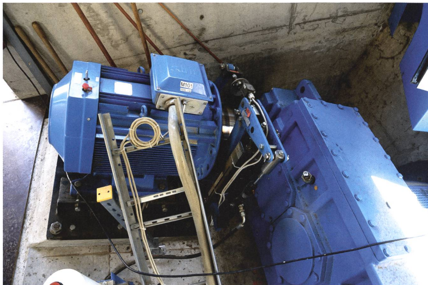
Der Generator hat eine Nenndrehzahl von 1000 U/min, später soll er durch einen mit Nenndrehzahl 1500 U/min ersetzt werden, der etwa 40 % mehr Leistung erzeugt.
