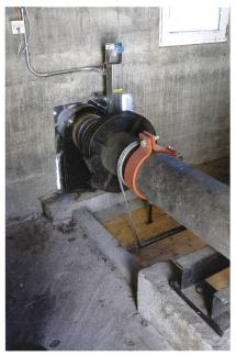
Ein Stahlseil betätigt die Antriebsachse der Stauklappe.
