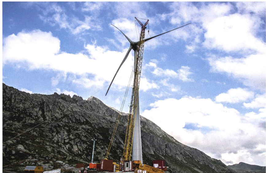
Mit einem Spezialkran werden die Komponenten für die Montage gehoben.
