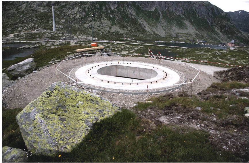
Im Fundament einer Windanlage sind 700 t Beton verbaut.
